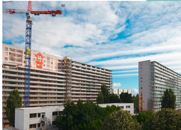
In Bordeaux wurde ein modernistischer Großwohnbau saniert, dabei dessen Qualitäten konsequent fortgesetzt und um großzügige Wintergärten und Balkone erweitert. © Foto: Philippe Ruault
